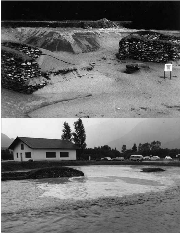
3 Überschwemmungsschäden im Bereich des Stadttors von Aguntum in den Jahren 1965 (oben) und 1966 (unten)
