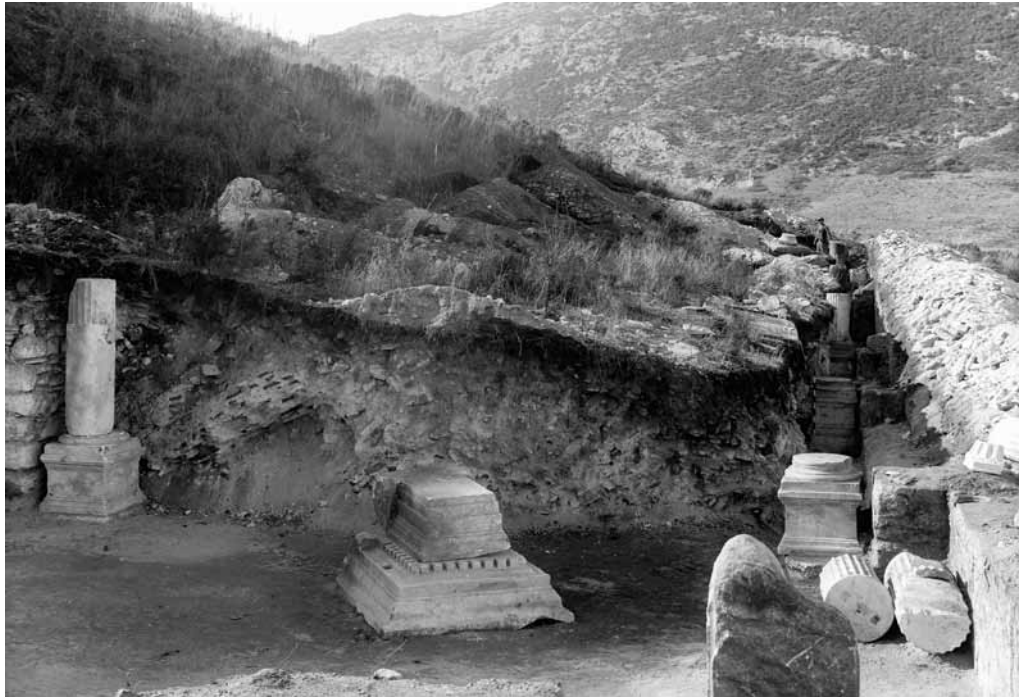
24 Versammlungsgebäude südlich der domus , Zustand bei partieller Freilegung 1930
