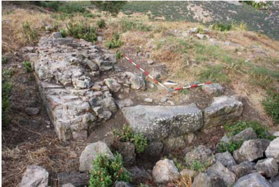
10 Nordostecke der bauzeitlichen Terrasse, Blick von Nordosten
