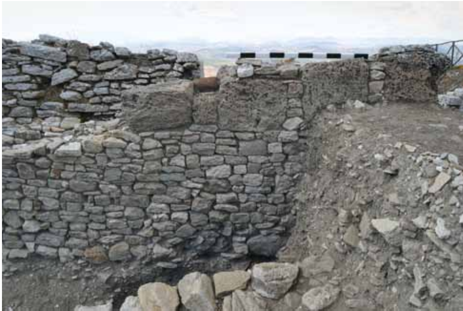
18 Westmauer PH 1 mit Tuffblöcken in den oberen Steinlagen (von Norden)
