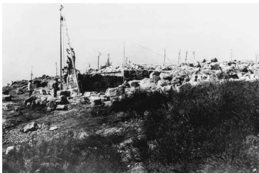
10 Velia, cd. terrazza di Zeus: lavori di anastilosi all'angolo sud-ovest del terrazzamento (1935)
