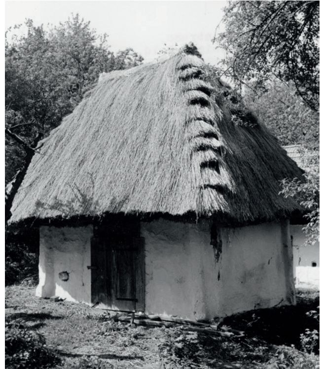
Abb. 2: Fruchtspeicher mit erneuertem Dach, Juli 1965
