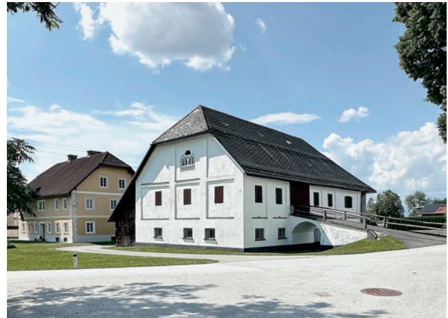
Abb. 3: Loibach, Bleiburg, Pfeilerstadel mit ablesbarer Pfeilerstruktur, 2023
