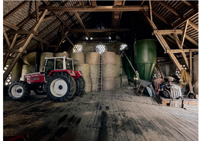
Abb. 2: Winkel, Feistritz ob Bleiburg, Innenansicht Pfeilerstadel Biohof Kotschnig, 2023
