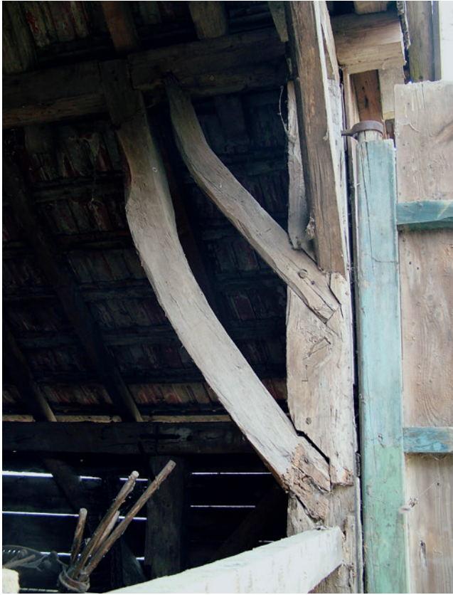
Abb. 4: Weinviertler Museumsdorf Niedersulz, Niederösterreich, Kopfbänder der Längsscheune aus Waidendorf, Aufnahme 2010
