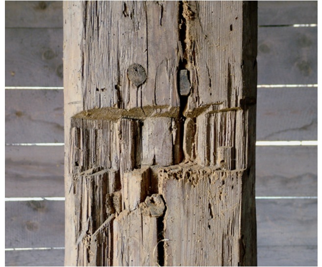
Abb. 7: Weinviertler Museumsdorf Niedersulz, Niederösterreich, Floßkeile an einem der Ständer, Aufnahme 2010
