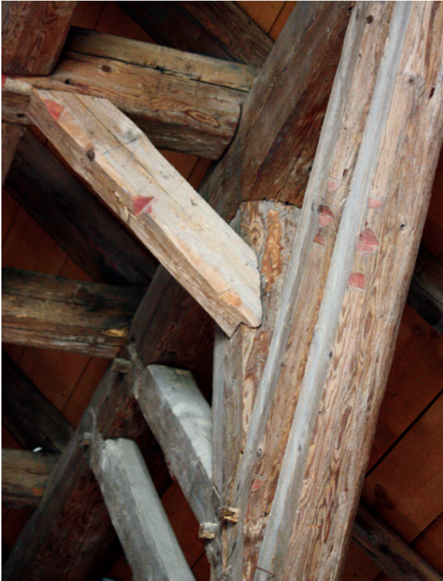
Abb. 5: Weinviertler Museumsdorf Niedersulz, Niederösterreich, Zierabfasungen der Kopfbänder der Längsscheune aus Zwingendorf, Aufnahme 2010
