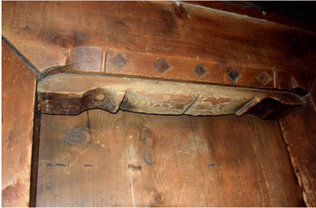
Abb. 8: Detail eines Türrahmens im Obergeschoss, Tauernhaus Spital, Aufnahme 2024
