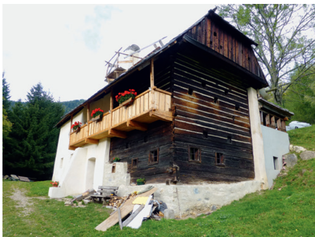
Abb. 9: St. Georgen ob Judenburg, Steiermark, Bauernhaus vulgo Giefer bei Abschluss der Sanierungsarbeiten, 2013
