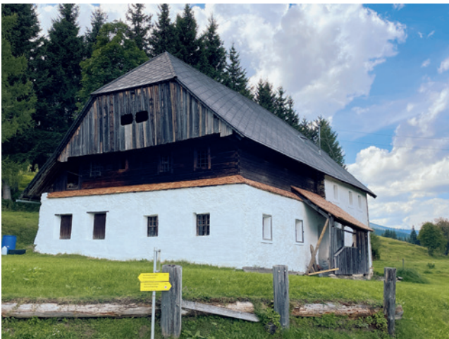
Abb. 11: Pölstal, Steiermark, Bauernhaus vulgo Schneeberger nach Abschluss der aktuellen Fassadensanierung und der partiellen Lärchenschindeldeckung
