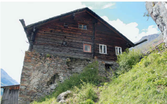
Abb. 5: Hof in Sölden Gaislach, Ostansicht, bedeutender Unterbau
