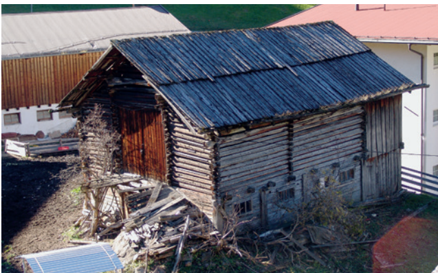
Abb. 13: Scharschindeldach, Wirtschaftsgebäude in Sölden
