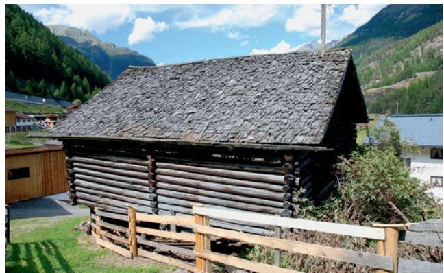
Abb. 14: Schindeldach, Wirtschaftsgebäude in Sölden
