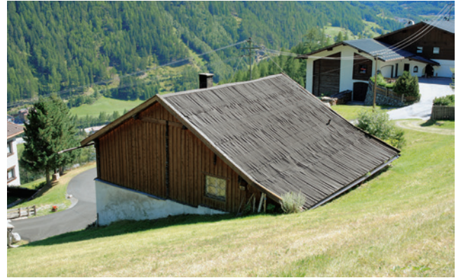
Abb. 8: Hof in Sölden, an Gelände angepasst
