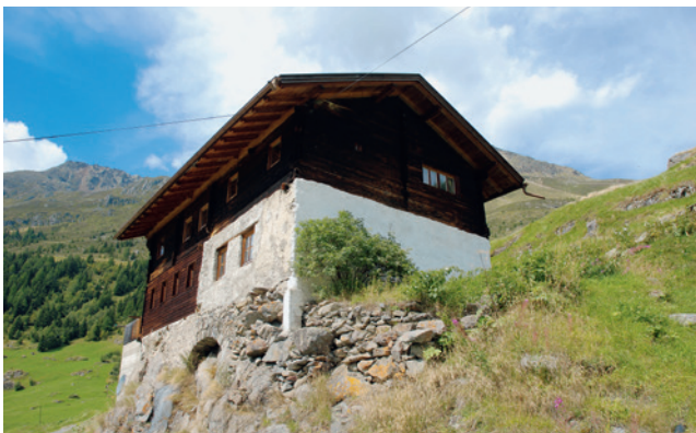
Abb. 30: Mischbauweise, Hof in Sölden Gaislach
