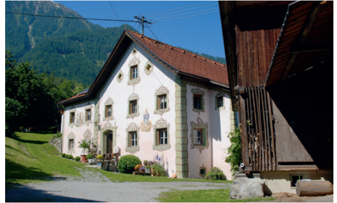
Abb. 29: Massiv gebauter Hof in Sautens
