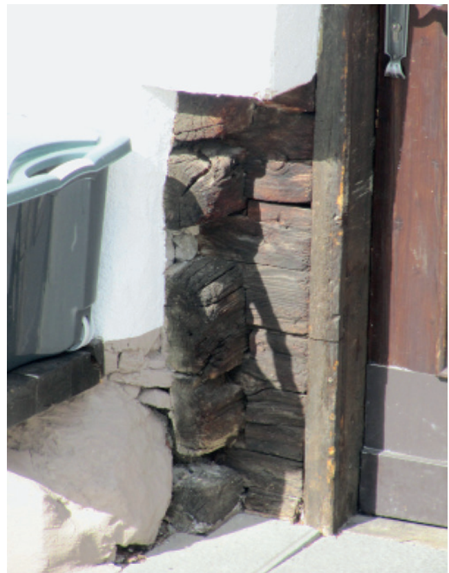
Abb. 27: Blockbau verputzt, Hof in Sölden
