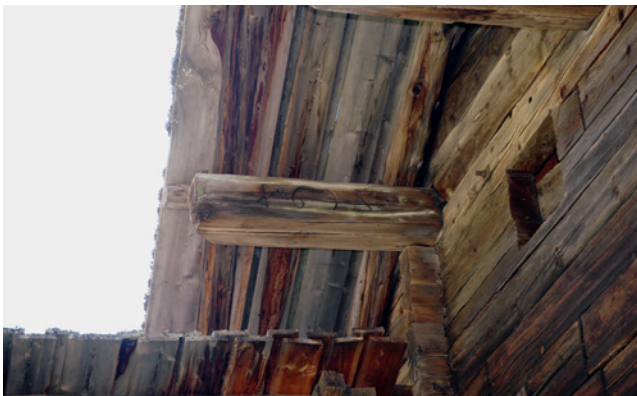
Abb. 17: Inschrift, Wirtschaftsgebäude in Sölden
