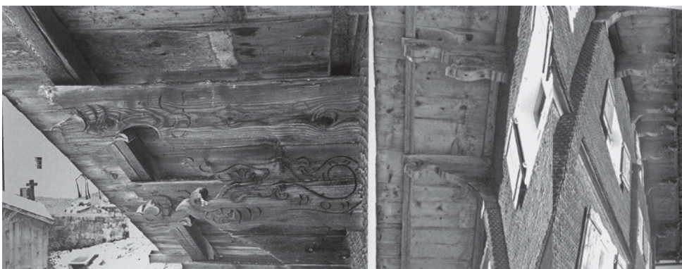
Abb. 9: Pfettenkopf- bzw. Unterzuggestaltungen, alter Pfarrhof in Innerberg, Bartholomäberg
