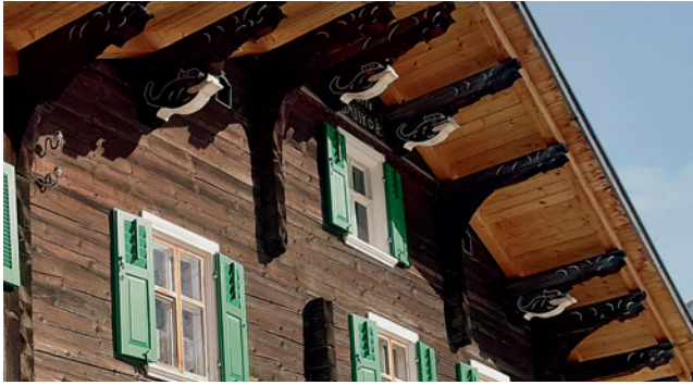
Abb. 7: Pfettenkopf- bzw. Unterzuggestaltungen, Wohnhaus Gaschurn-Partenen
