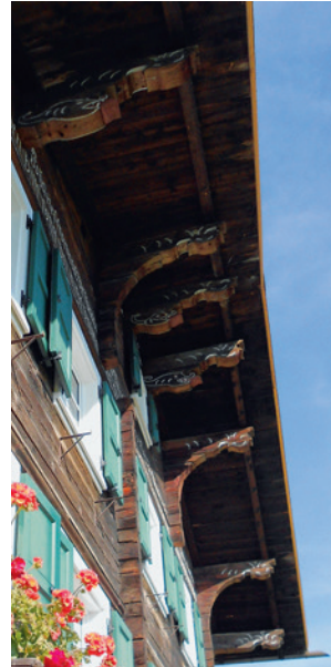
Abb. 8: Pfettenkopf- bzw. Unterzuggestaltungen, Wohnhaus in Innerberg, Bartholomäberg
