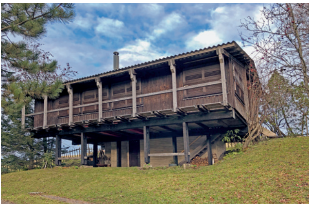
Abb. 3: Ferienhaus für den Vater, „Am Bödele“, Vorarlberg, Gunter Wratzfeld, erbaut 1966
