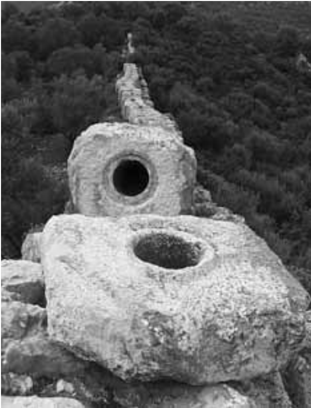
Abb. 23 Druckröhre von Norden in Fließrichtung
