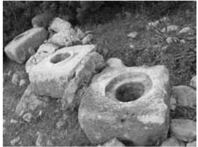
Abb. 35 Verstärzte Steinröhre beim Delikkemer
