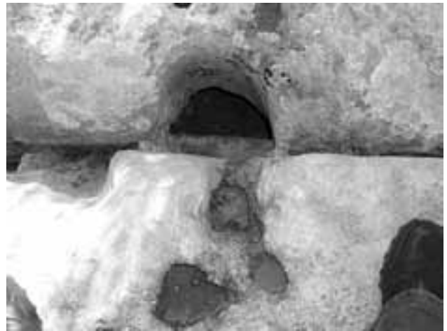
Abb. 37 Halbkreisförmiges Loch auf herausnehmbarem Steinrohr
