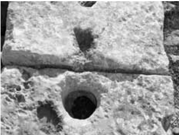
Abb. 36 Steinrohrglieder mit Entlüftungsloch und Klammerloch
