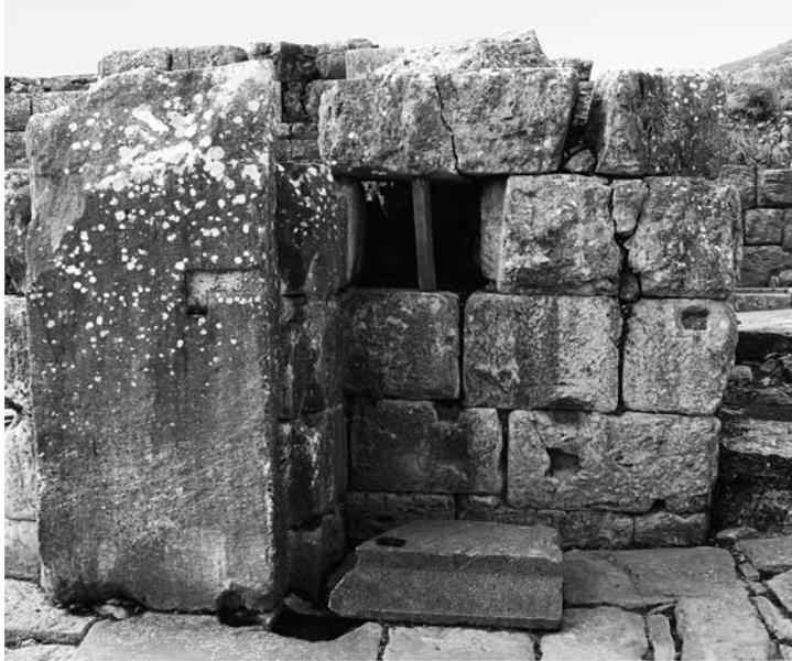
18 Nördlicher Mittelpfeiler mit zugesetztem Schubriegelloch
