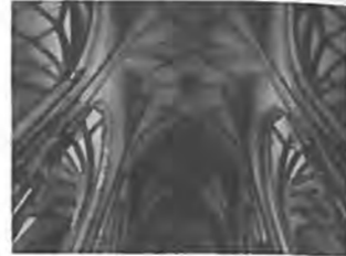
6 Peter Kodera Blick in das Mittelschiff- gewölbe mit Sprengriegen des Domlanghauses von St. Stephan, 1965–1970 Fotografie
